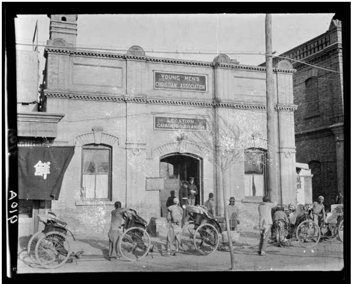
YMCA Building 基督教青年会总部 北京 Beijing, 1918年
